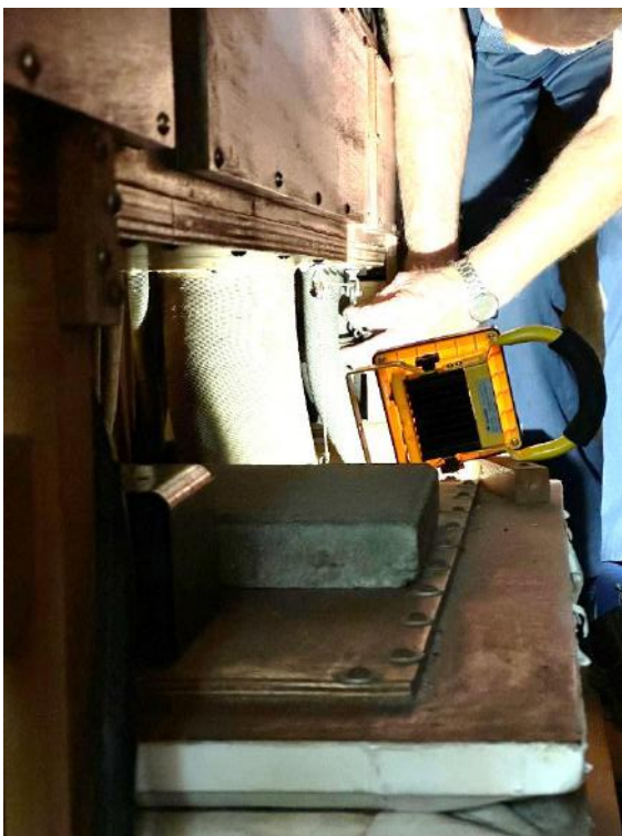
Het rolgordijn kastje moest worden uitgebouwd voor reparatie van het nylondraadje.
